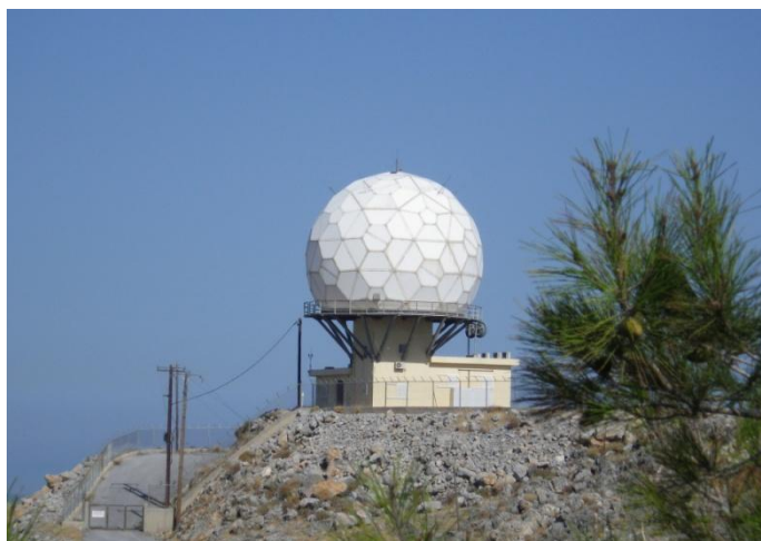
Εικόνα 1: Άποψη της εγκατάστασης του ραντάρ ελέγχου εναέριας κυκλοφορίας στο Ηράκλειο Κρήτης
