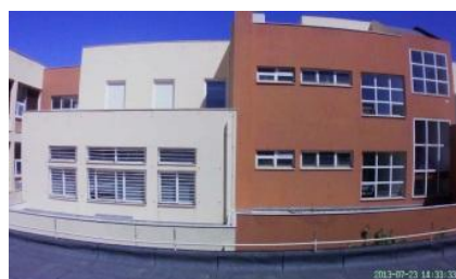
Εικόνα 2β:Εξωτερικό πεδίο ελέγχου - Απόσταση εστίασης 15m
